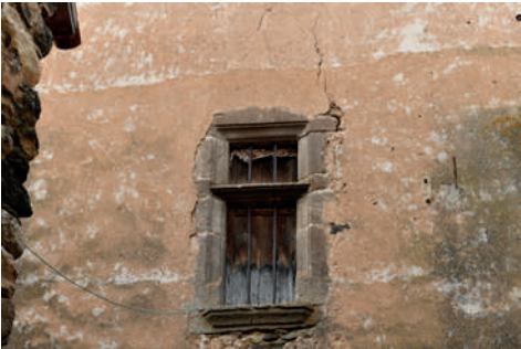
Fenêtre à meneaux
