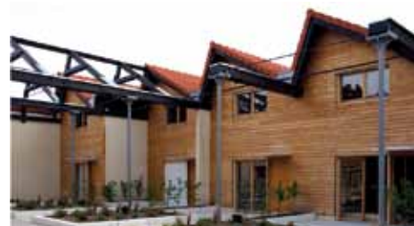
Axis Architecture, L. Thomassin - Réhabilitation du bâti industriel en logements - OPAC 43 Le Puy-en-Velay (43)
