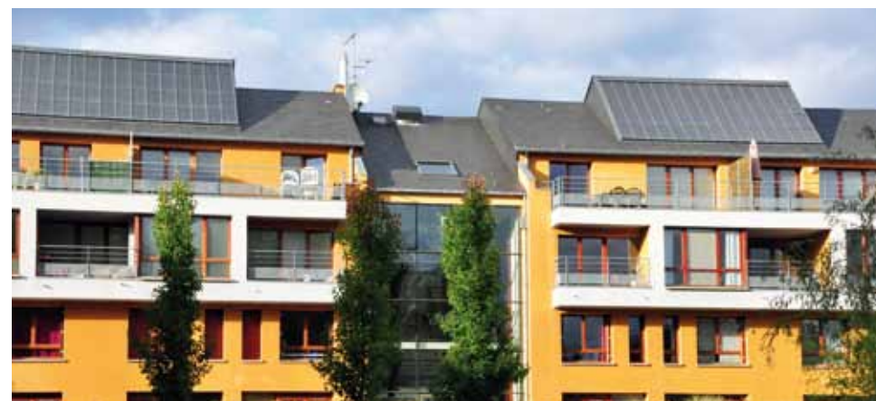
Intégration du chauffage solaire, Mordelles (35)
