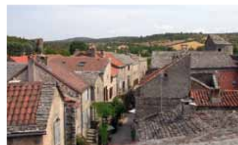
Compacité du bâti, La Couvertiroade (12)
