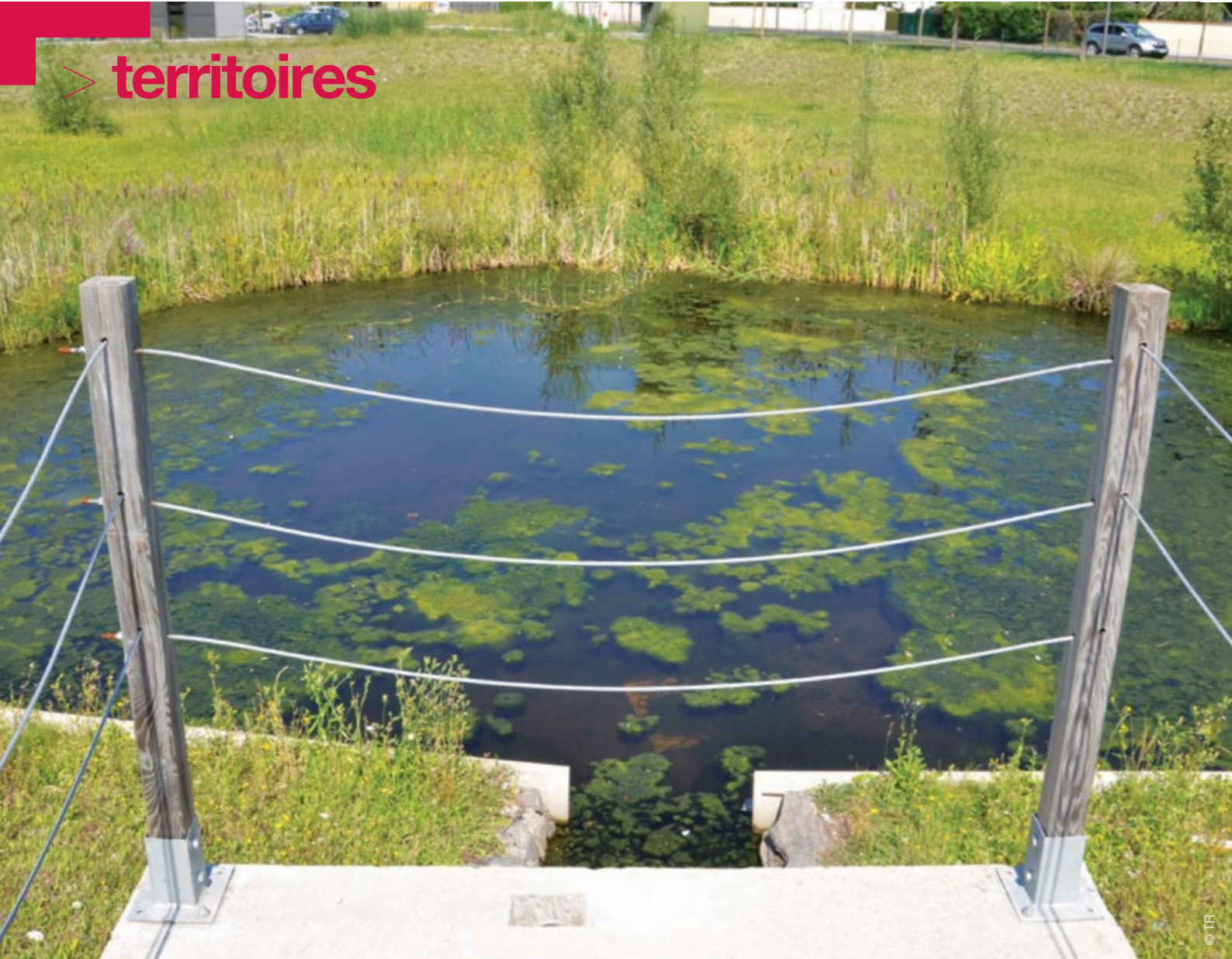
Bassin d'orage à Cournon d'Auvergne
