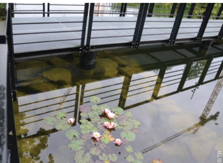
Bassin de phytoépuration à Nantes
