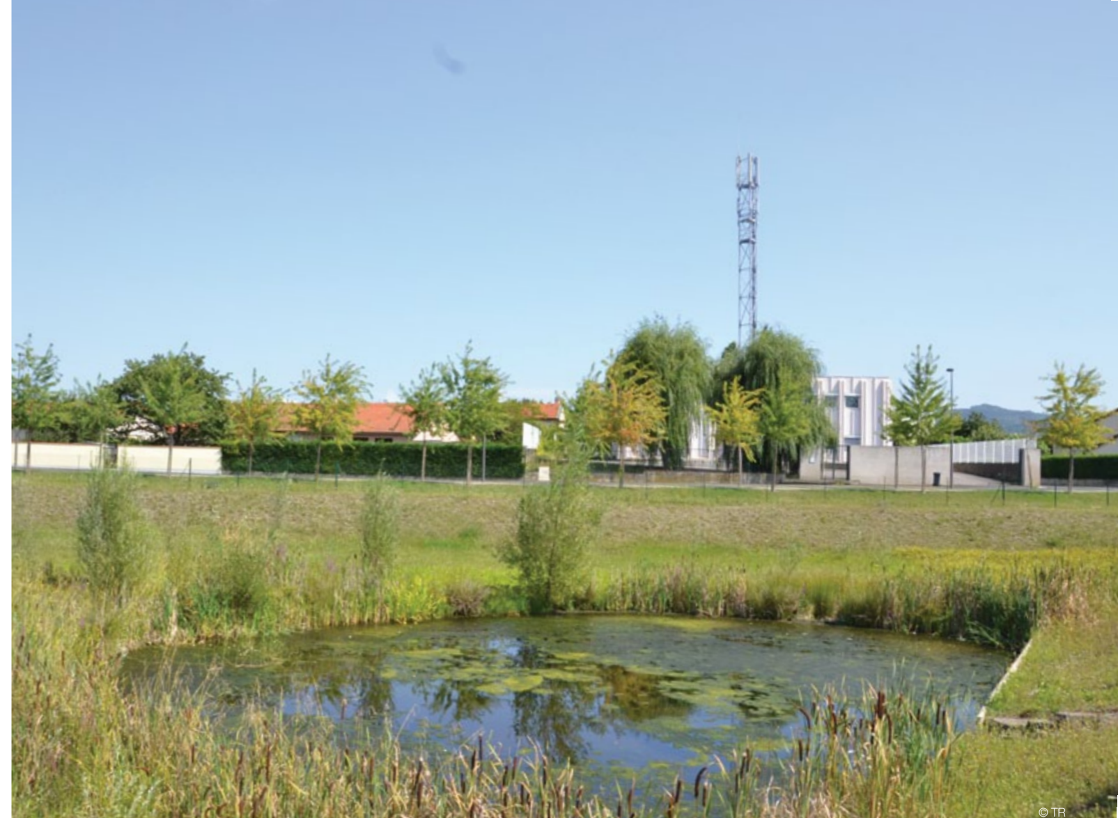
Bassin d'orage végétalisé
