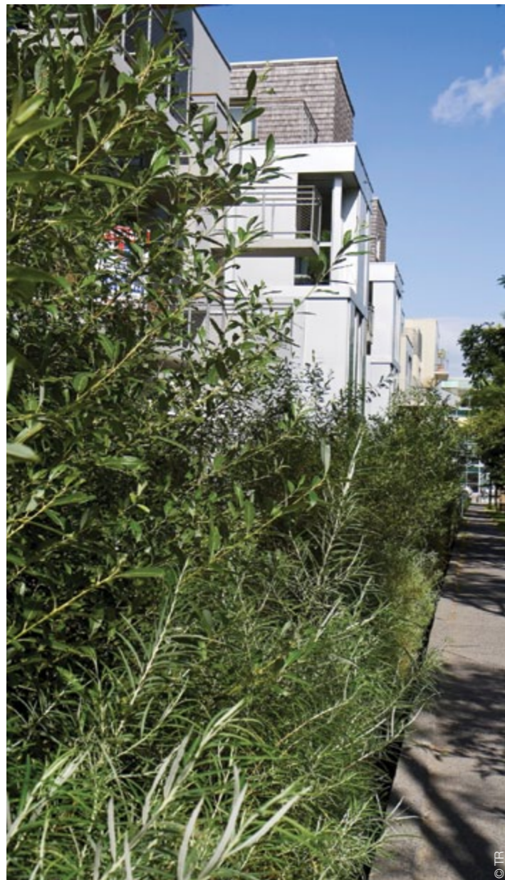
Fossé drainant en pied de façade - LILLE
