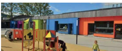
Maître d'ouvrage : Commune de Clermont-Ferrand Maître d'œuvre : M2o Marcollin - Thuillier architectes
