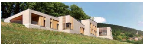
Maître d'ouvrage : Communauté de communes de la Montagne Thiernoise Maître d'œuvre : Agence Boris Bouchet architecte & atelier du Rouget Simon Teyssou et associés
